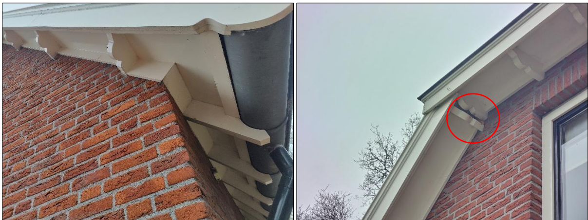
Foto: Geen kieren of gaten in gemetselde muur, boeiboorden en dakranden. Hoeken zijn dicht gemaakt met purschuim (rode cirkel).
