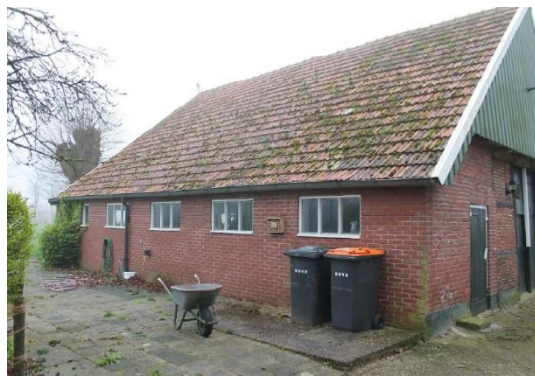
De rechterzijgevel met de nieuw muur en openingen
