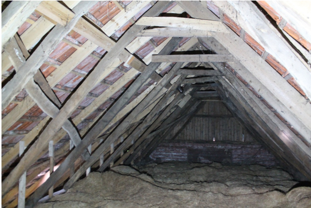
Sporenkapconstructie op zolder
