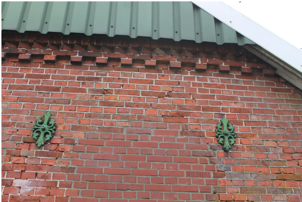
Bouwsporen in metselwerk van oorspronkelijke raamkozijnopeningen en 'muizentand' bovenlangs
