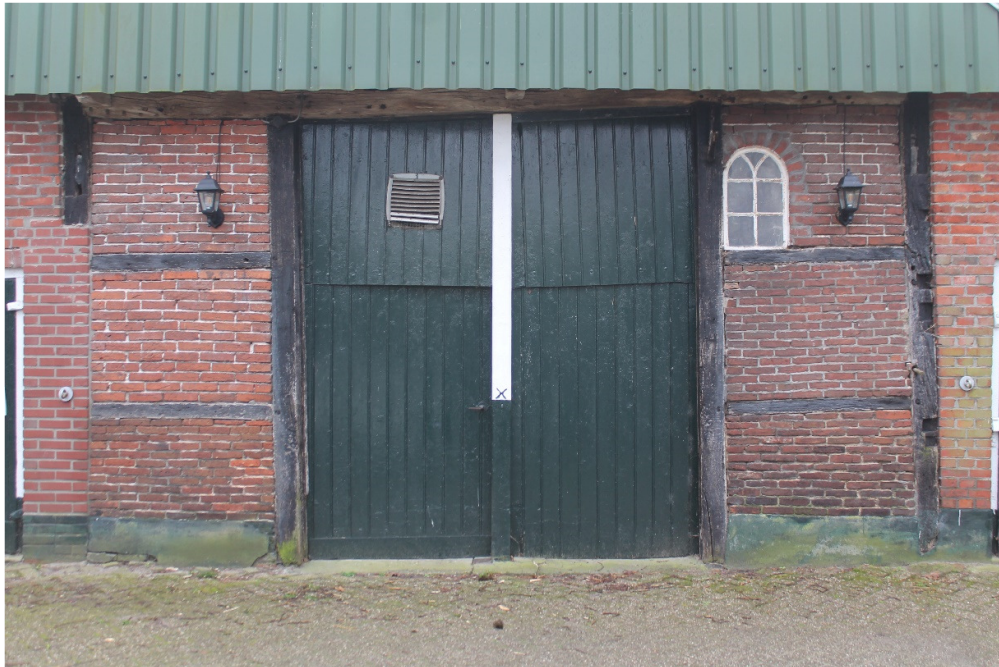
Oude vakwerkgevel, baanderdeuren en stiepel Noordgevel
