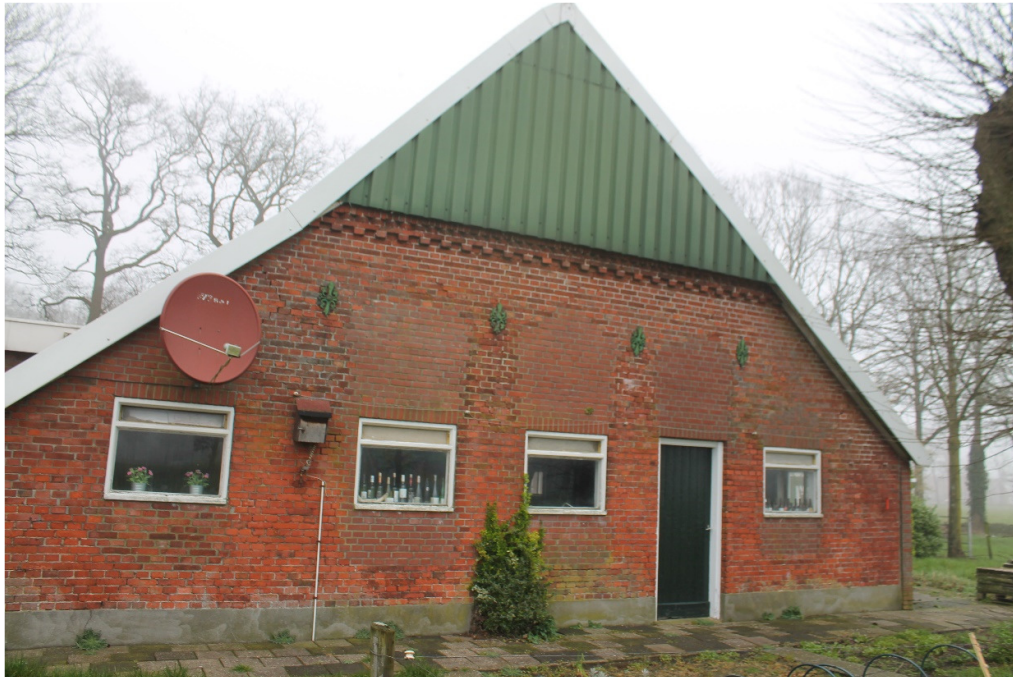
Zuidgevel met bouwsporen van oorspronkelijke raamkozijnen
