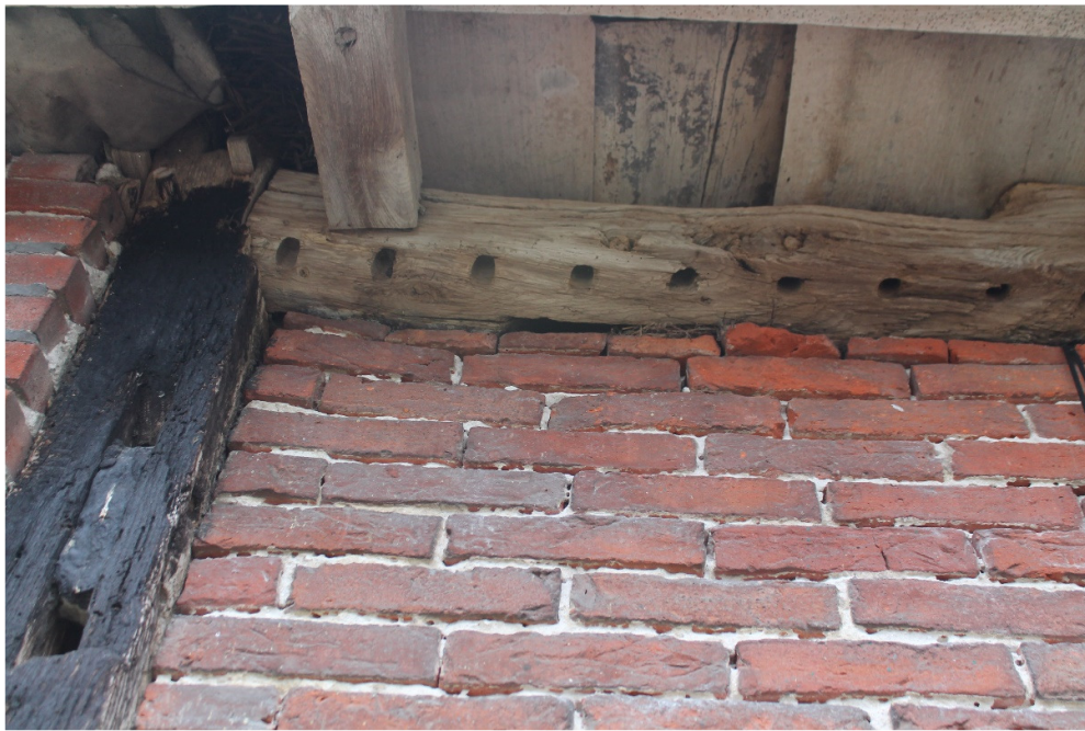
Bouwsporen/fitsgaten oude lemen vakwerkgevel
