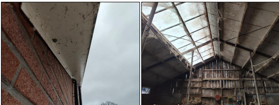
Gezette profielen als windveer maken de bebouwing langs de daklijsten ontoegankelijk, houten koude gevels bieden geen verblijfplaats.
