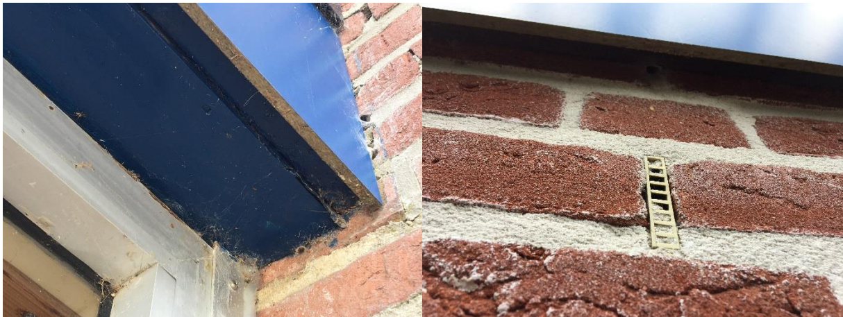
Foto links; de houtbetimmering sluit naadloos aan op de buitengevels. Foto rechts; de open stootvoegen zijn afgesloten met bijenbekjes.
