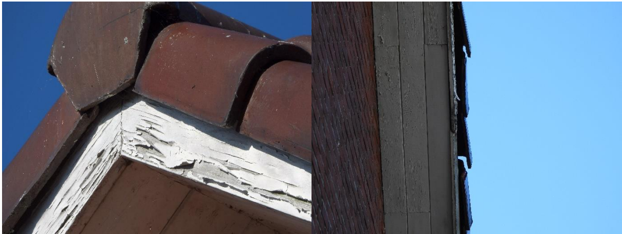
Foto links; onder de nok zijn openingen vastgesteld. Foto rechts; De gevelpannen sluiten niet nauw aan op de betimmering van het dak waardoor er openingen ontstaan.
