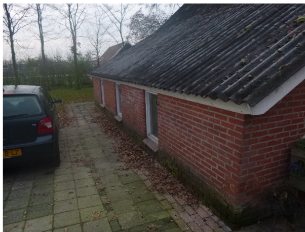
Oostzijde te slopen schuur
