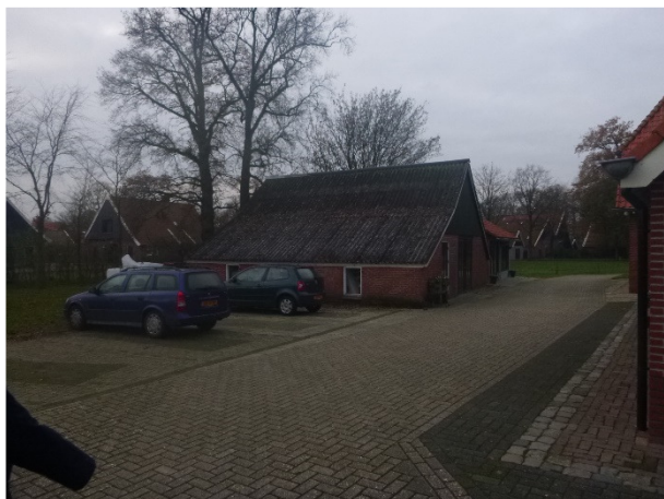
Te slopen schuur
