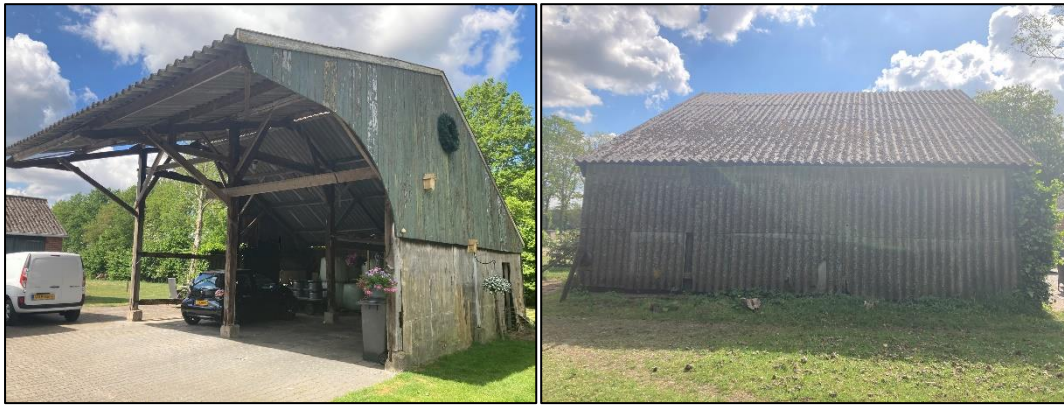
Figuur 2.3 (links): Impressie van een van de te slopen kapschuur; Figuur 2.4 (rechts): Achteraanzicht van de schuur als vernoemd in figuur 2.3.
