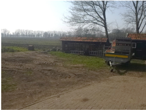
Te slopen overkapping met houtopslag
