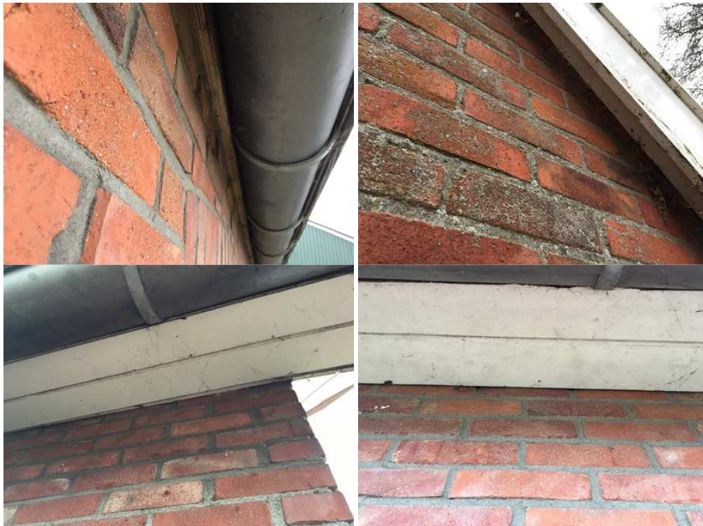
Daklijsten en windveren zijn naadloos op de buitenmuur bevestigd. Dit biedt vleermuizen geen mogelijkheid om de woning te binnen te komen.
