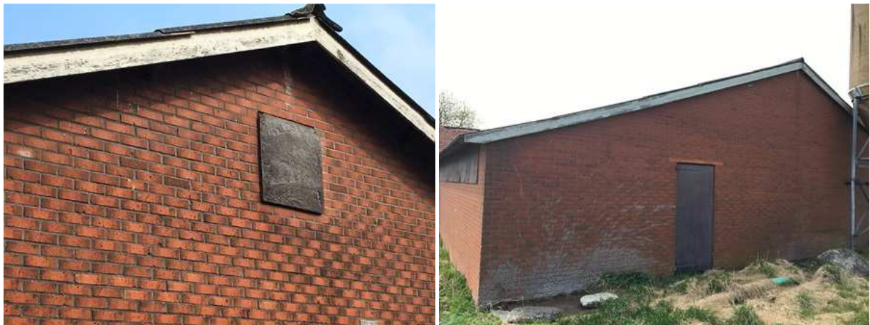
Gevels zonder open stootvoegen of andere potentiële invliegopeningen die vleermuizen de kans bieden een verblijfplaats te bezetten in de spouw van de stal.
