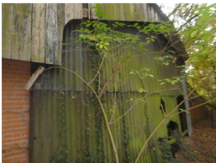
Onduline beplating veeschuur 1
