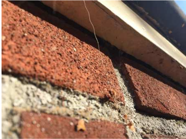
Detailopname van de daklijst langs de woning. De daklijst is strak tegen de buitengevel bevestigd. Hierdoor kunnen vleermuizen de spouw niet bereiken om er een verblijfplaats te bezetten.
