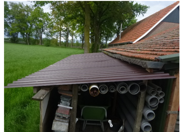
Overkapping achterzijde te slopen schuur
