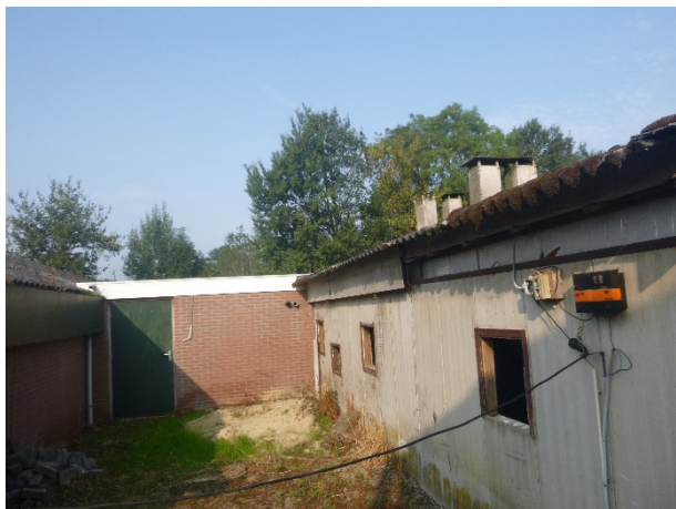
Links de te behouden varkensschuur en rechts de zuidelijke te slopen varkensschuur
