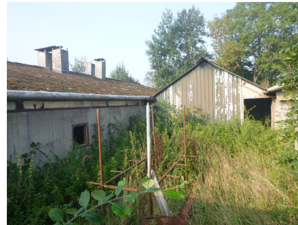
Ruimte tussen te slopen schuren
