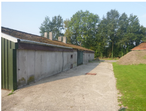
Noordelijke te slopen varkensschuur
