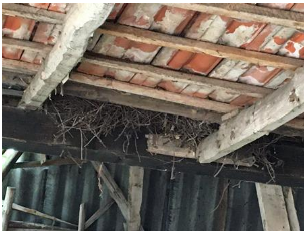
Oud kauwennest in de te slopen schoppe.
