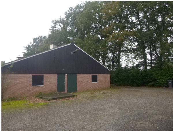
Erf richting voormalige kippenstal
