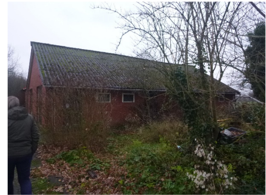
Te slopen varkensstal
