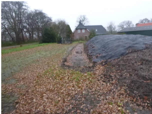
Overtollige verharding onder kuilvoer
