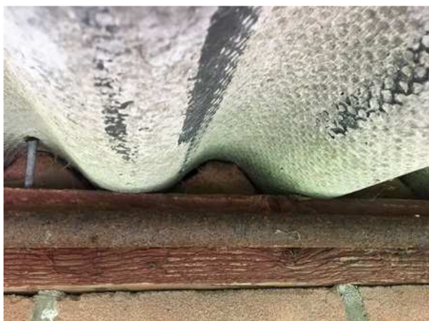
Afdichtingen van de openingen onder golfplaten. Hierdoor kunnen grondgebonden zoogdieren, zoals steenmarters, geen verblijfplaats bezetten in de holle ruimte tussen de golfplaten en dakisolatie.
