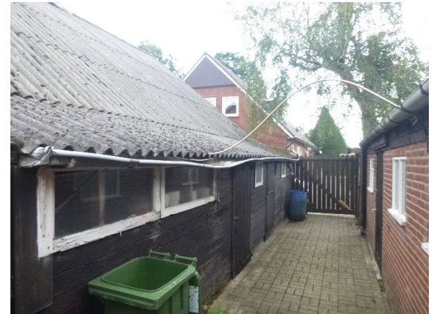
Ruimte tussen varkensstallen
