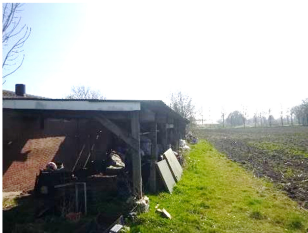
Overkapping schuur met druppelzone D
