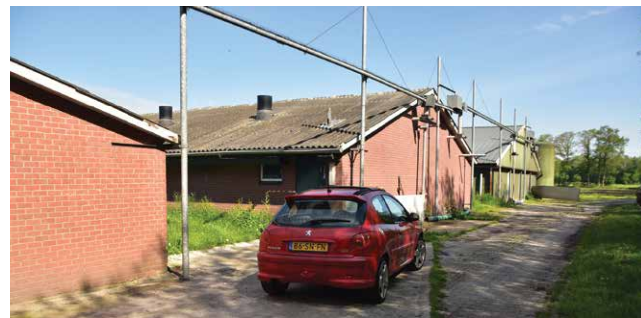
Werkgedeelte, de meest linkse schuur wordt gesloopt.
