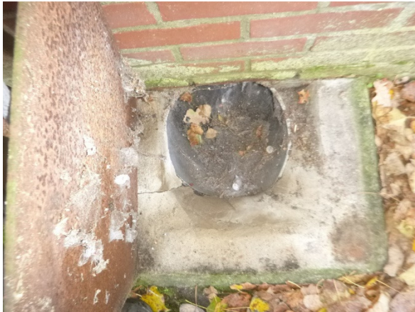
Inspectie pomp gat
