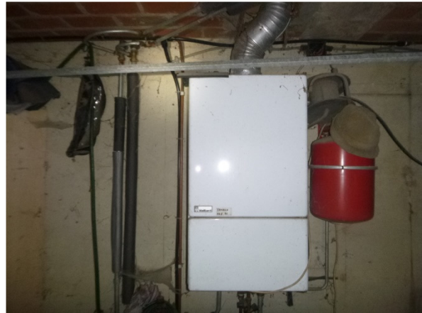
Cv-ketel asbestvrij
