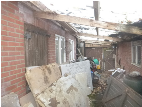
Afdak met lichtplaten tussen schuren 1 en 3
