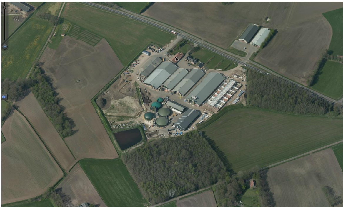
Figuur 2: Luchtfoto bestaande erf + elementen omgeving (bron Globespotter)
