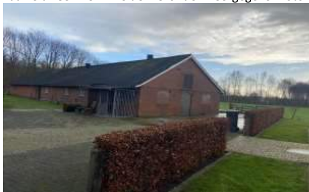
Figuur 1: Te slopen schuur
