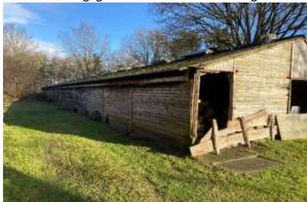
Figuur 1: Te slopen schuur
