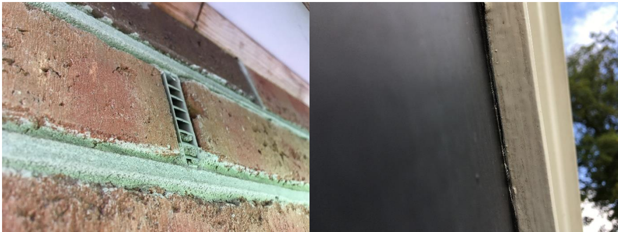
Foto links; de open stootvoegen zijn gevuld met bijenbekjes. Foto rechts; de houten topgevel is voorzien van folie.
