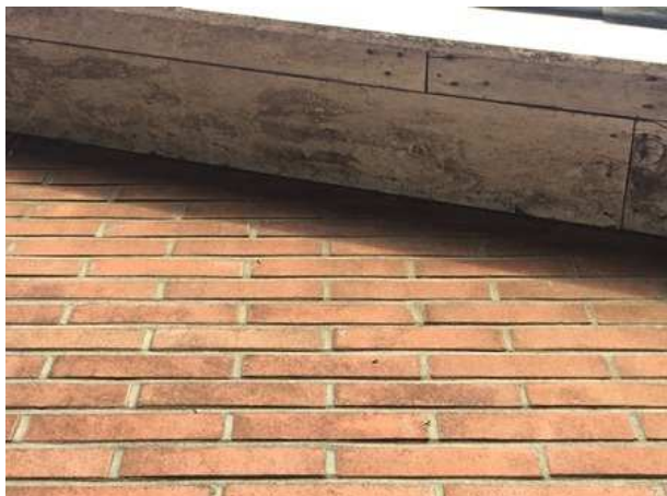
Detailopname van de varkensstal. De daklijst is strak tegen de buitengevel bevestigd. Hierdoor kunnen vleermuizen de spouw niet bereiken om er een verblijfplaats te bezetten.
