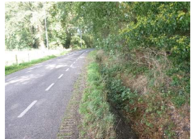
Te verleggen weg nabij rotonde
