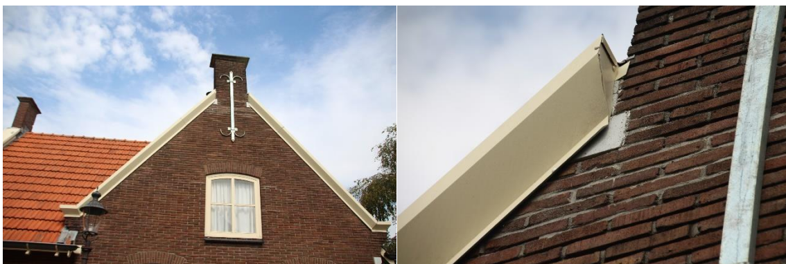
Brede windveer met opening aan de onderzijde. Dit biedt vleermuizen de kans een verblijfplaats te bezetten achter deze windveer.
