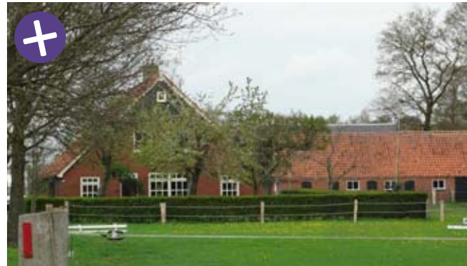
Rode baksteen in combinatie met een pannendak
