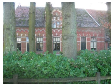
Het belemmert zicht op de voorgevel van de boerderij vanaf de Denekamperweg.
