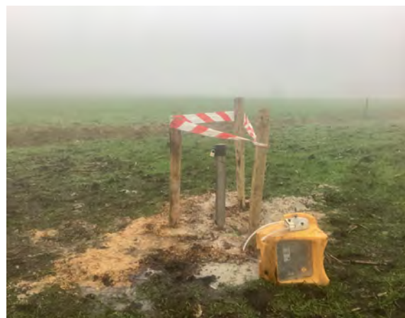
Foto monitoringspeilbuis bij installatie
