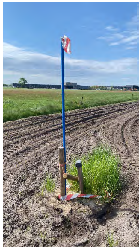
Foto monitoringspeilbuis beschadigd aangetroffen (mei 2025)
