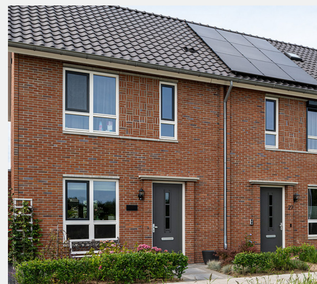
Dakoverstek met ingetogen gootdetail
