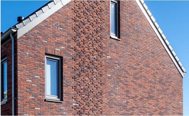
Ambacht 2: reliëf in het metselwerk vormt een decoratief patroon
