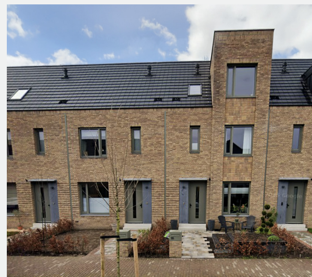
Uit de gevel oprijzende dakkapel is nadrukkelijk onderdeel van de compositie van het bouwblok
