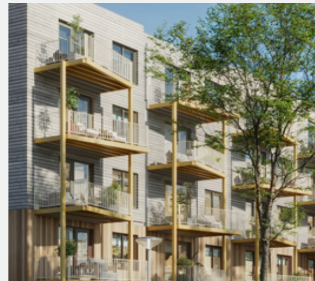
Kolommen verbinden balkons
