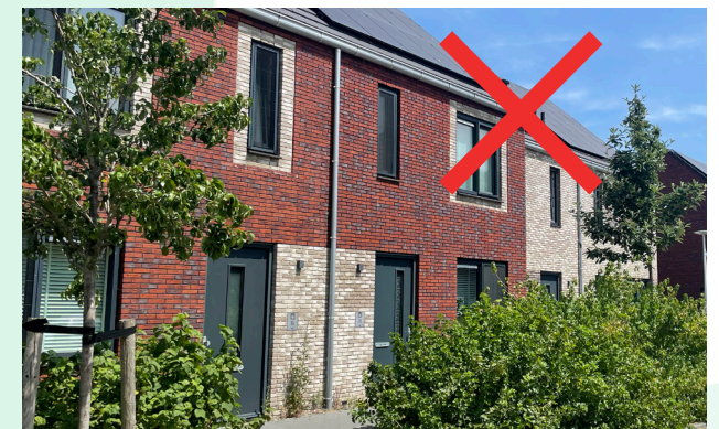
Gevel met vlakken in verschillende kleuren: niet gewenst
