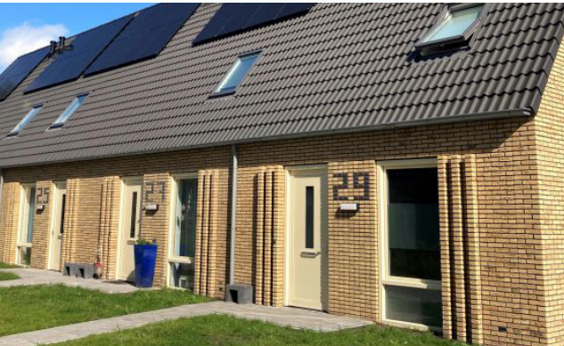
Ambacht 3: 'penanten' in het metselwerk
