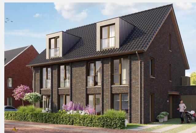
Rijk in metselwerk detail
