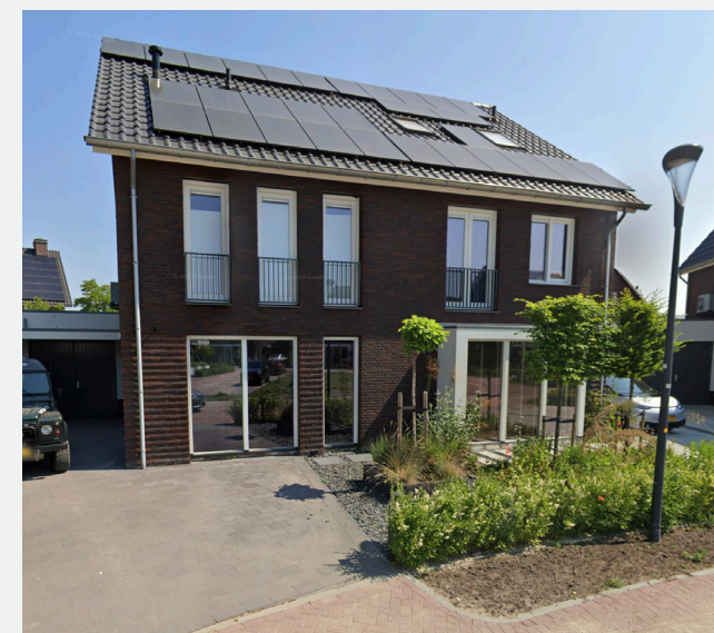
Asymmetrische gevelindeling met metselwerk details
