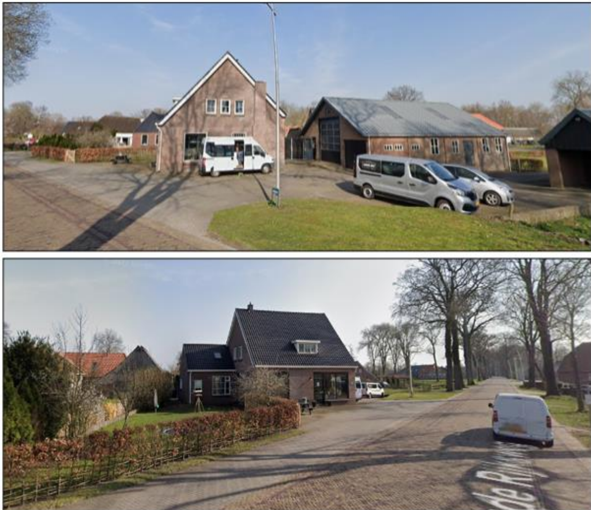
Afbeelding 2.1: Straatbeelden van plangebied vanaf de Oude Rijksweg (Bron: Google Streetview)
