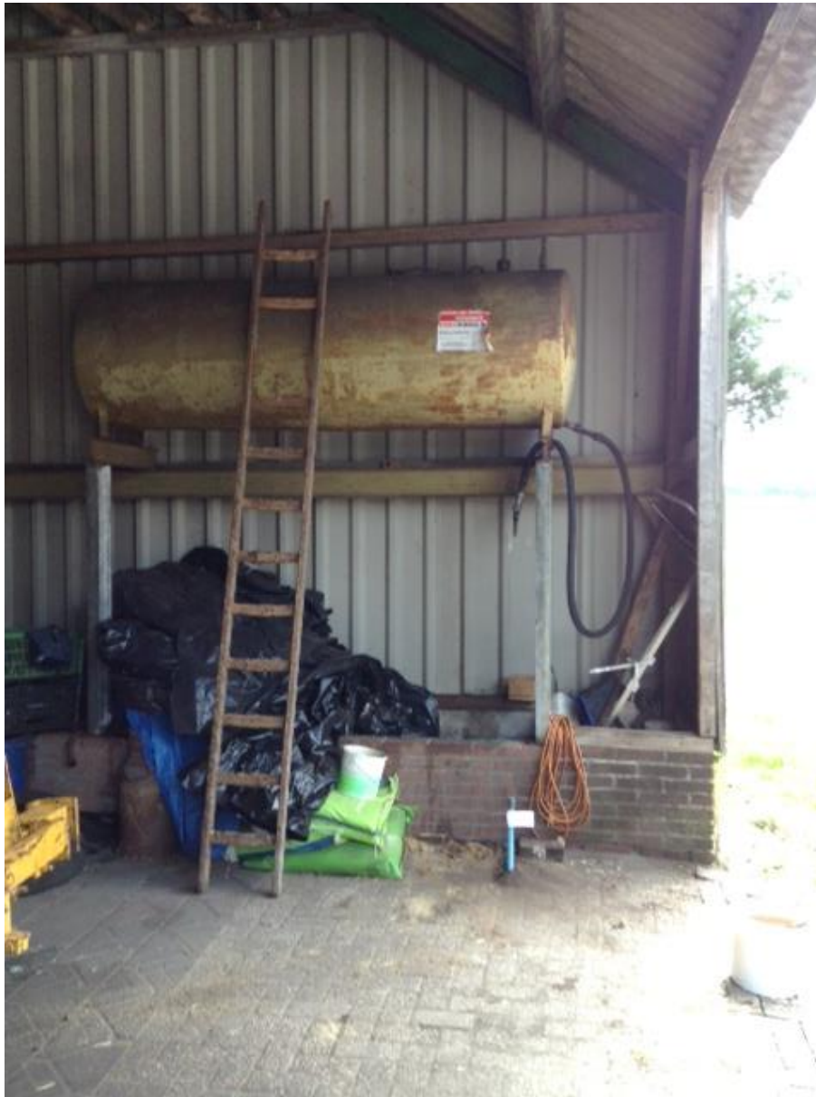
Foto 4: bovengrondse dieselolietank
