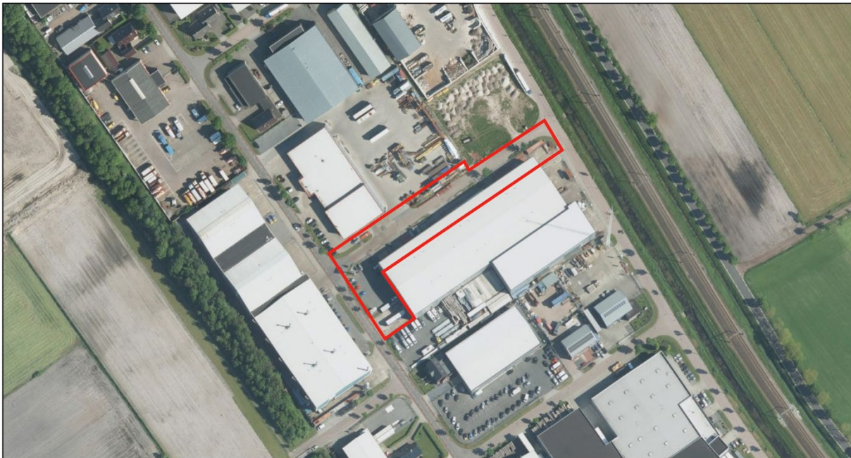
Afbeelding 2.1 Luchtfoto huidige situatie (Bron: topotijdreis.nl)
