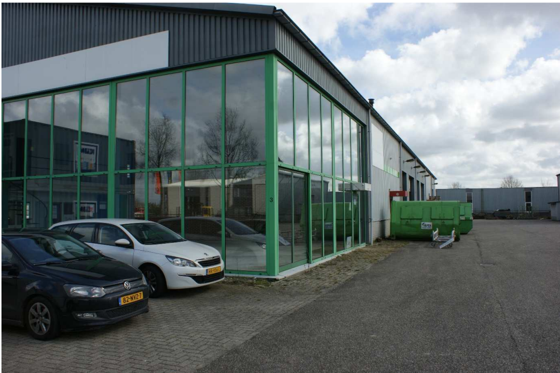
Figuur 2.3. Leegstaande loods
