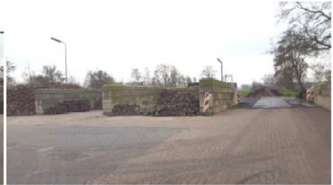
Afb. 04: foto verhard (klinkers) terrein met depot met keerwanden en doorgang het zuidelijke deel.
