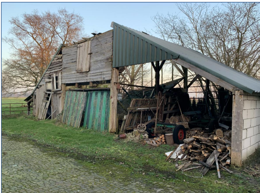
Fig. 4.5: Weergave van de voormalige bijgebouwen op het perceel dat voor de sloop al deels op instorten stond.
