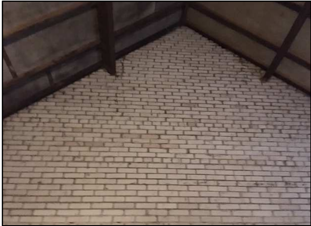
Te slopen woning aanzicht dak
