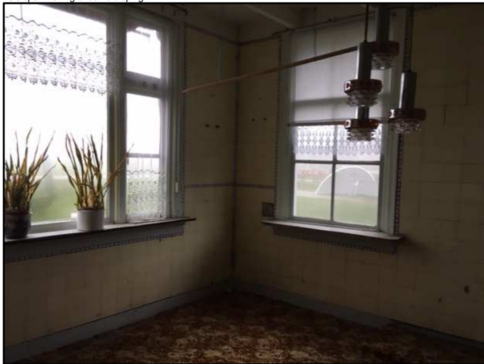
Te slopen woning onderverdieping
