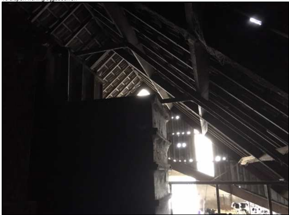
Te slopen woning aanzicht naar rundvee stal
