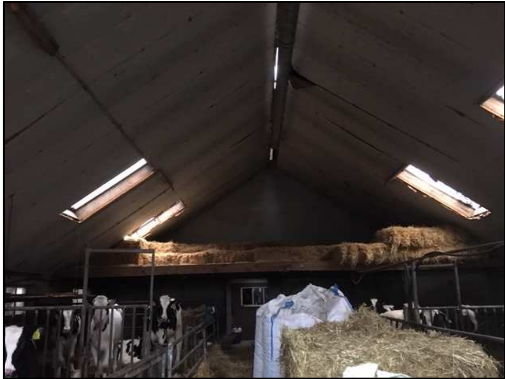
Binnenzijde te slopen jongvee stal
