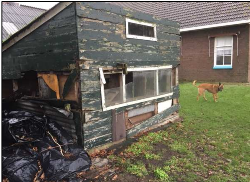
Te slopen gebouwen
