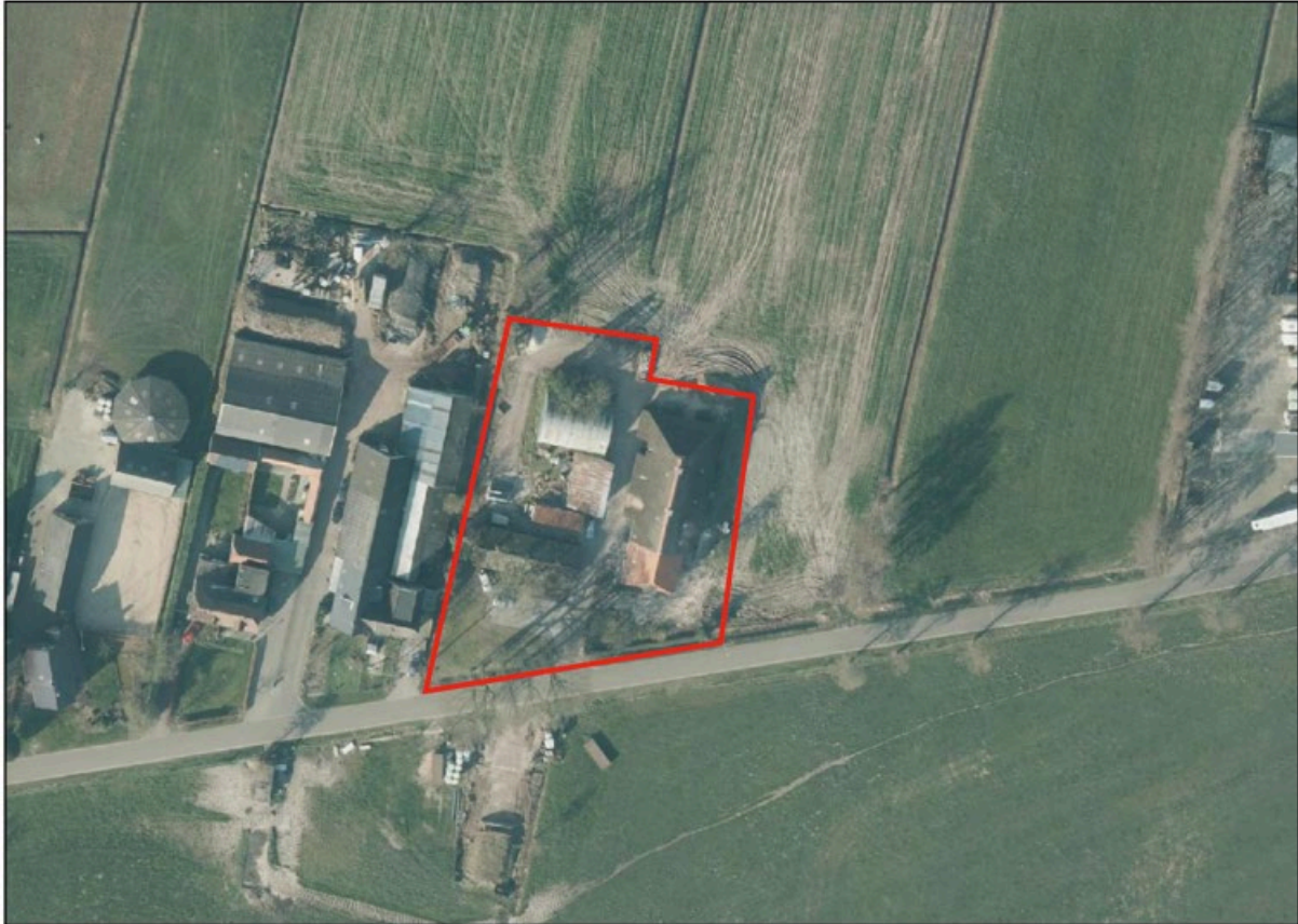
Afbeelding 3.1 Luchtfoto plangebied (Bron: PDOK, bewerkt)
