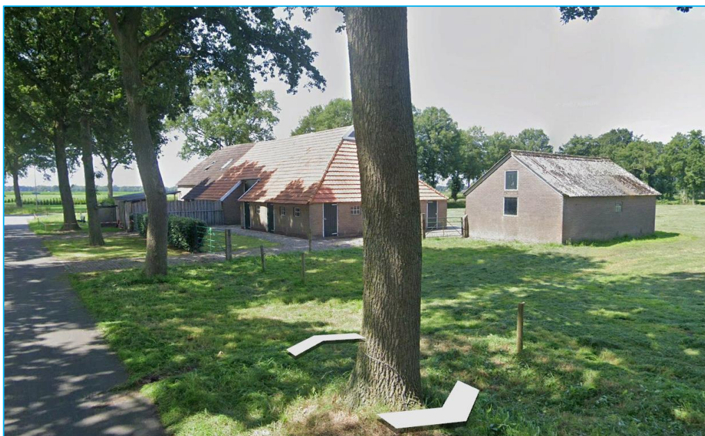
Aanzicht op de woning Buitenstouwe 4 gezien vanaf de achterkant met aan de rechterkant de te herbouwen schuur en de te slopen schuur
