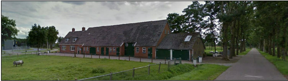
Afbeelding 2.2 Straatbeeld huidige situatie Rijksparallelweg 25 gezien vanaf Schuthekkeweg (Bron: Google Streetview)
