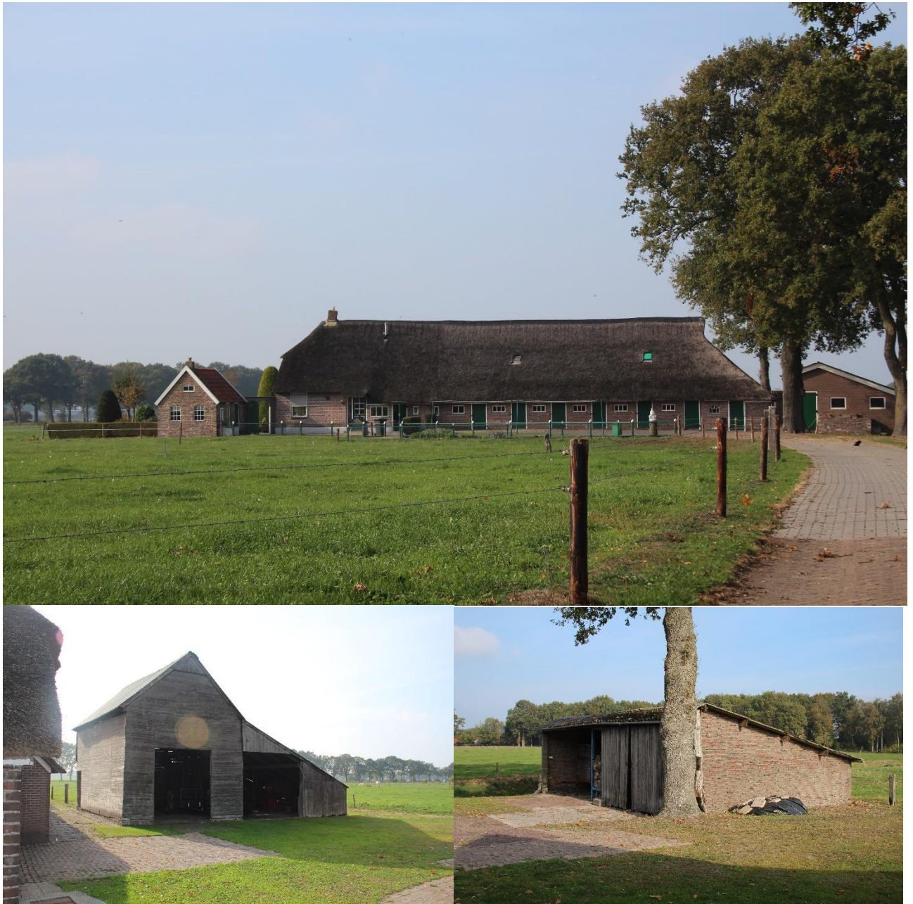
Figuur 3. Foto met de te slopen achterhuis en de bijgebouwen.
