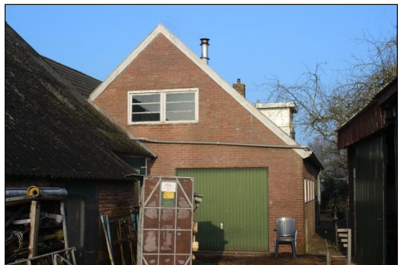
Afb. 9: achterzijde woonhuis vanaf het zuiden.
