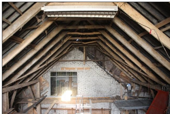
Afb. 8: binnenzijde van de te herbouwen kapschuur.
