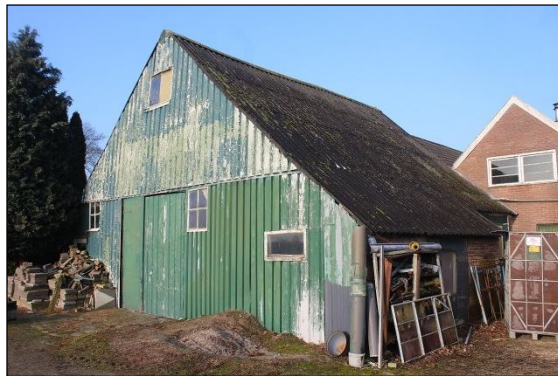
Afb. 6: de te slopen en te herbouwen kapschuur.
