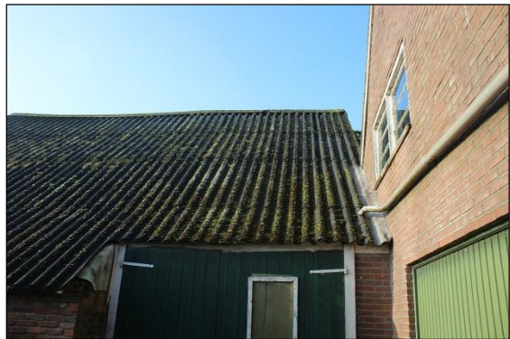
Afb. 7: dak van de te herbouwen kapschuur.
