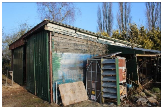
Afb. 11: te slopen losstaande schuur.
