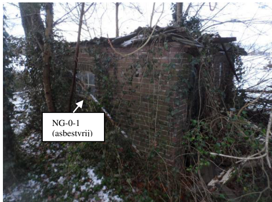
Foto 7: Geïntervieweerde schuur 1 vanuit noordoostelijke richting gezien. Stopverf betreft identiek materiaal aan MM-0-1.
