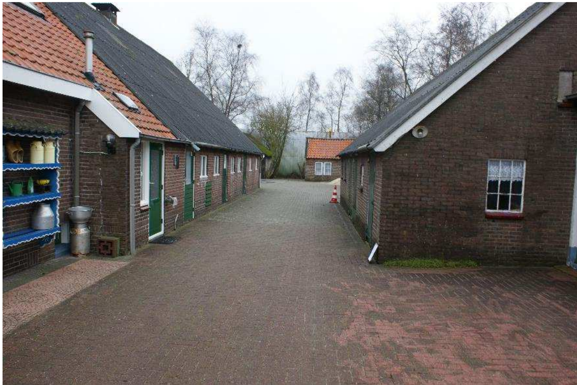
Figuur 2.3. Overzicht erf tussen beide boerderijen, met op achtergrond te slopen schuurtje en te slopen romneyloods
