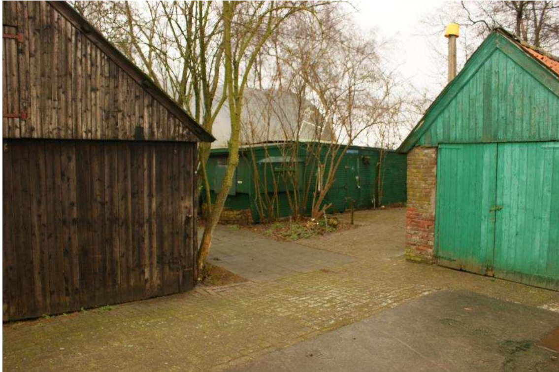
Figuur 2.5 Tweetal te slopen schuren met daarachter stacaravan en de te slopen romneyloods.
