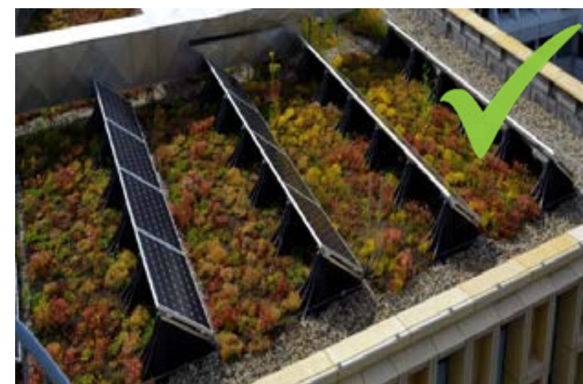
Zonnepanelen dragen bij aan een duurzamer bedrijf
