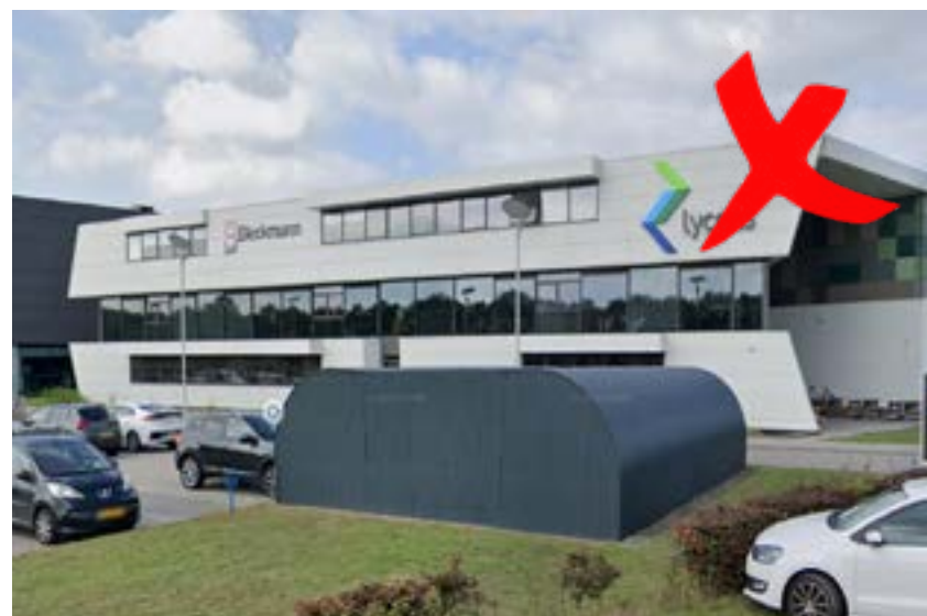
Reclame uitingen maximaal één maal per gevel
